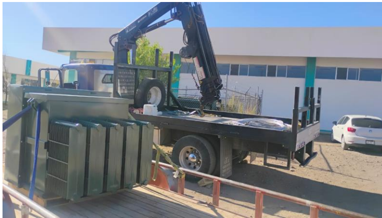
Ilustración 39 Reposición de Transformador Eléctrico. Fuente Depto. de Fuente Depto. de Recursos Materiales y Servicios.
