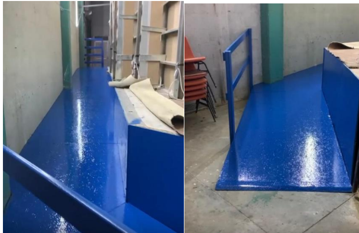
Ilustración 43 Mantenimiento en rampas y escaleras en el Gimnasio. Fuente Depto. de Fuente Depto. de Recursos Materiales y Servicios.
