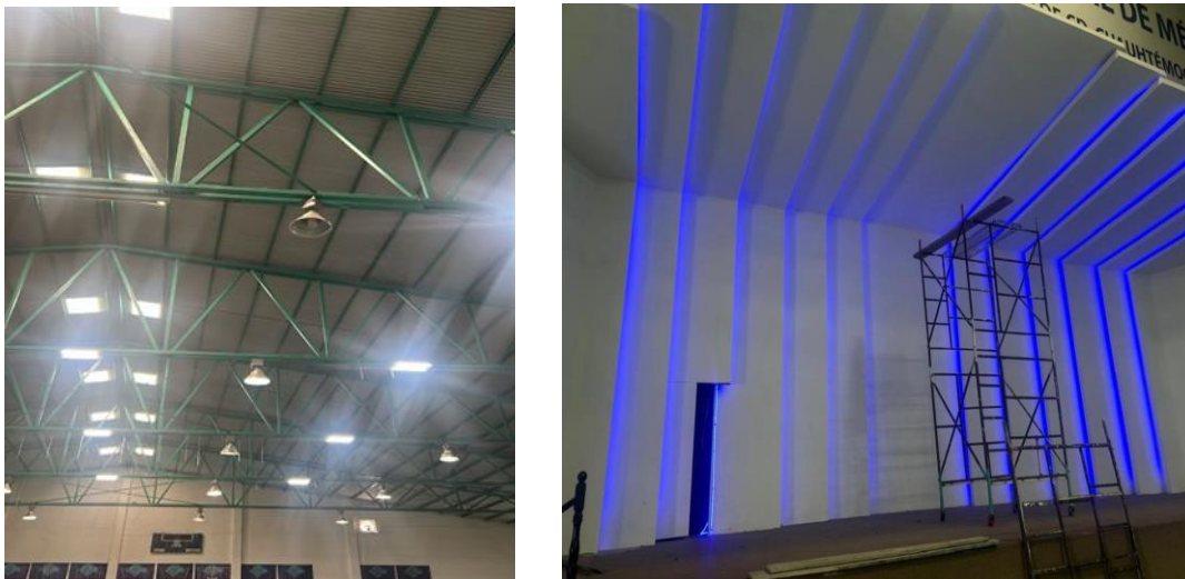
Ilustración 44 Mantenimiento y Reparación de Luminarias. Fuente Depto. de Mantenimiento y Equipo
