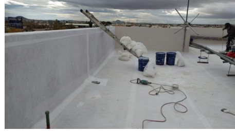
Ilustración 17 Impermeabilización de Edificios
