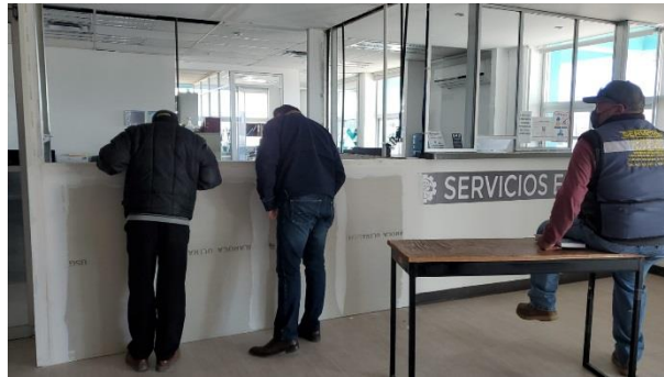
Ilustración 19 Modificación al Departamento de Escolares. Fuente Depto. de Mantenimiento
